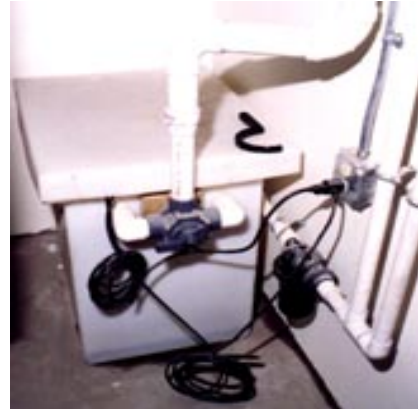
Prefiltro para água de pia usada para irrigação num pequeno canteiro externo.
